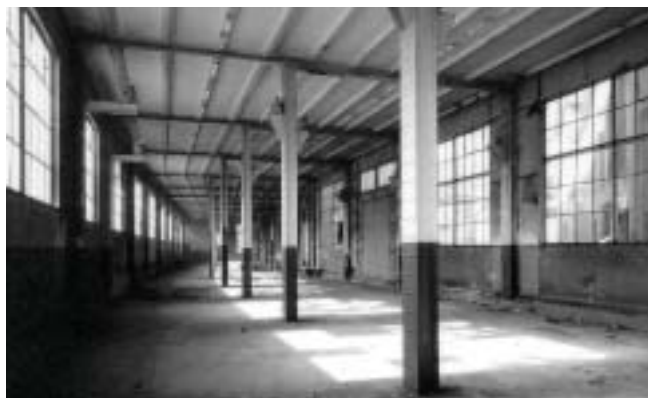
Pohled do interiéru haly G 48 před konverzí
