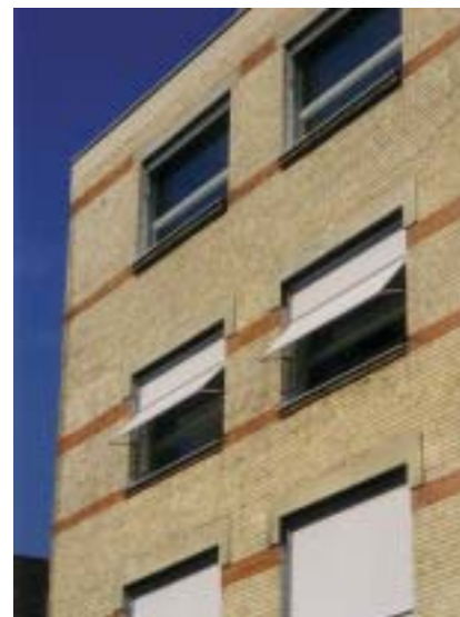
Technopark, detail fasády, stínící prvky
