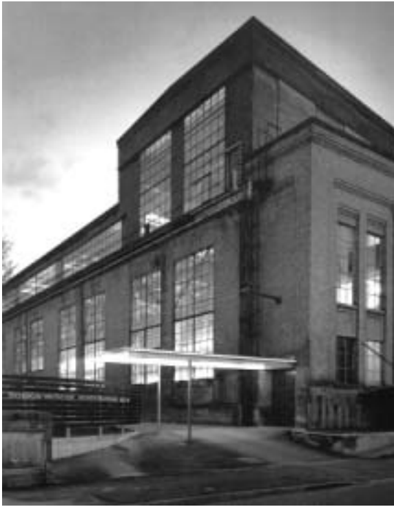
Hala 180, vstupní část
