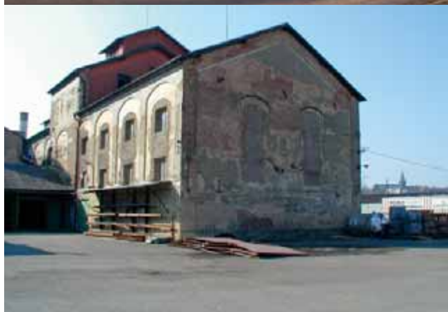
Areál Chrudim před rekonstrukcí
