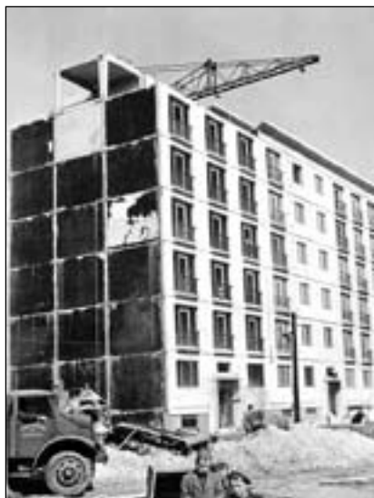
Výstavba panelového domu
