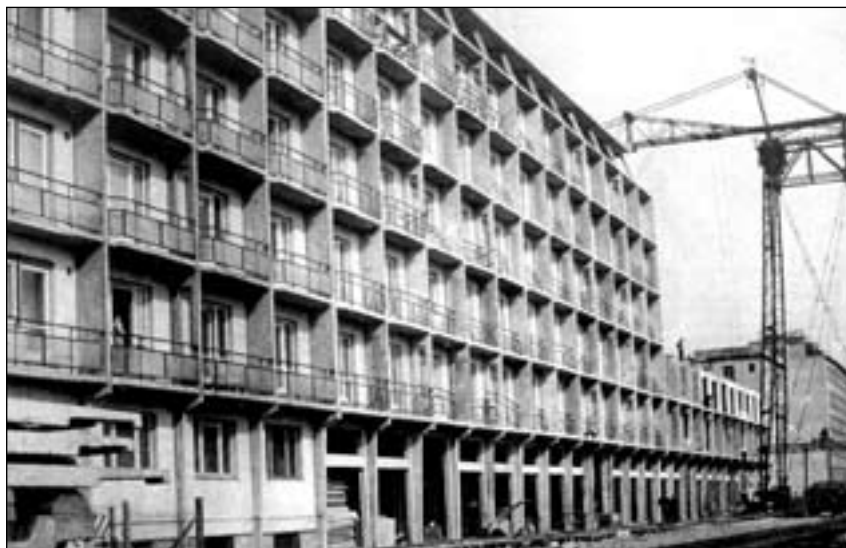
Výstavba panelového domu
