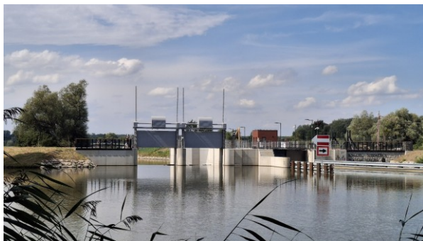
Obr. 43: Jez a plavební komora Rohatec-Sudoměřice na Baťově kanálu
