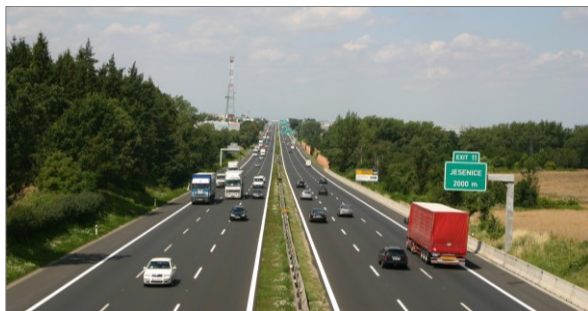
Obr. 7: Dálnice D1, směr Praha.
