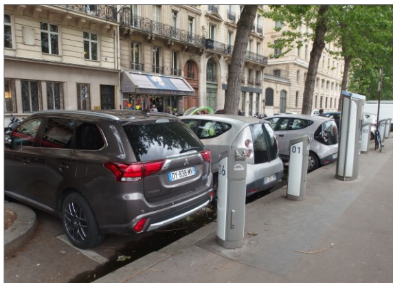
Obr. 61: Veřejná půjčovna aut s nabíjecí stanicí pro elektrická vozidla, Paříž.
