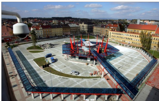
Obr. 50: Dopravní terminál v Chebu.
