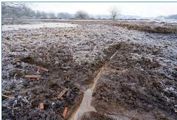
Obr. 52 a 53 Křižovatka“ drenáží nalezená v prostoru největší z tůní. Bagrování jílové clony pod tůní. Foto Vojtěch Šťastný
