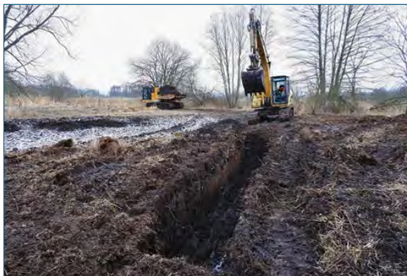
Obr. 52 a 53 Křižovatka“ drenáží nalezená v prostoru největší z tůní. Bagrování jílové clony pod tůní. Foto Vojtěch Šťastný
