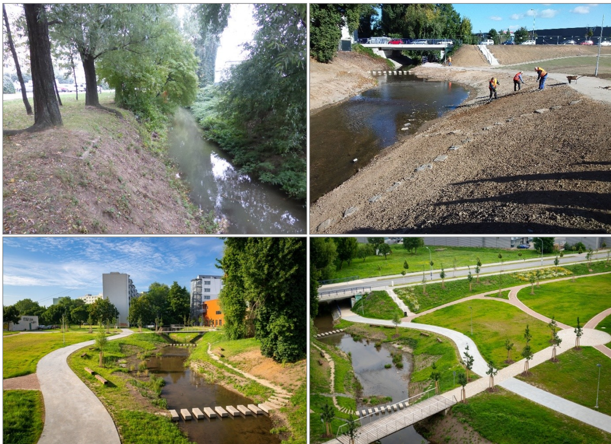
Obr. 32 až 35 Příklad návratu části říčky Ponávky v Brně Komárově do přírodní podoby. Vlevo nahoře původní stav před úpravou, vpravo nahoře stav během realizace v roce 2019. Dole výsledná podoba revitalizace toku s navazujícím parkem.
