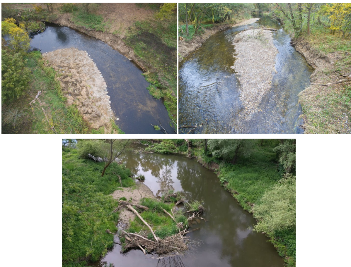
Obr. 27 a 28 a 29 Řeka Morava u Štěpánova, morfologické prvky může na základě přírodních vzorů vytvořit i člověk. Všechny prvky na leteckých snímkách jsou vytvořeny stavební činností, i když se to nejméně na posledním snímku snad ani nezdá. Foto: Povodí Moravy, s.p., 2020.
