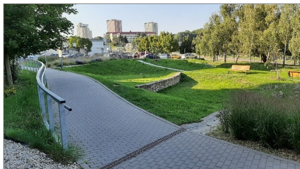
Obr. 61 a 62 Součástí výstavby Aquaparku v Brně-Kohoutovicích byl požadavek na řešení vsakování dešťové vody z celého areálu koupaliště. Výsledkem jsou suché nádrže s parkovou úpravou, které jsou využívány pro rekreaci. Stavba byla realizována v roce 2010. Foto: Z. Kučerová, 2023
