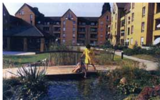
Obr. 2: Bývalý areál pivovaru Schlegel v Bochumi nyní sloužící bydlení.
