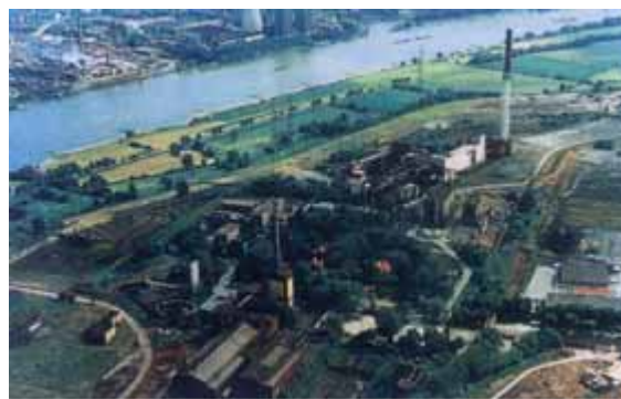
Obr. 1: Uprostřed bývalého areálu hutí v Duisburgu-Rheinhausenu leží památkově chráněná kolonie vil, jejíž střechy upravené do původního stavu jsou rozeznatelné ve středu obrázku.
