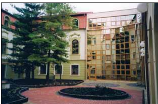
Atrium radnice po rekonstrukci
