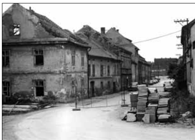
Havlíčkova ulice před demolicí
