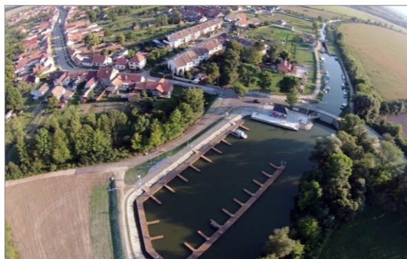
Obr. 42: Přístav na Baťově kanále, Petrov.
