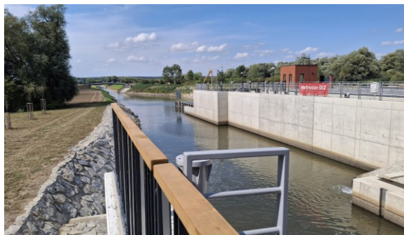
Obr. 44: Jez a plavební komora Rohatec-Sudoměřice na Baťově kanálu
