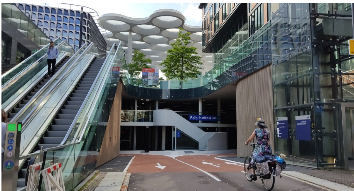
Obr. 17: Parkovací dům pro kola, nádraží Utrecht Centraal. Kapacita parkovacího domu je 12 500 jízdních kol v několika úrovních. Zahrnuje také dílny s obsluhou i samoobslužné.
