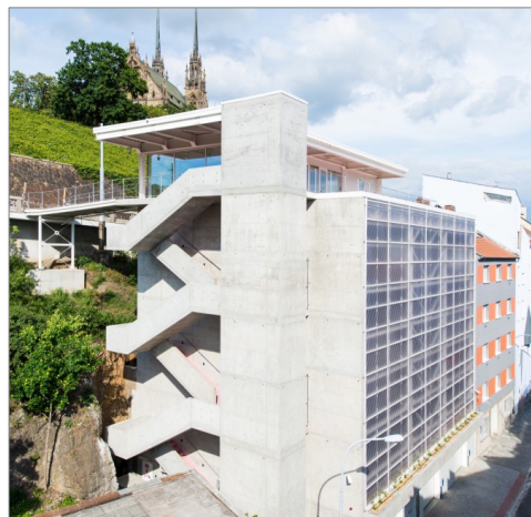
Obr. 53: Automatický parkovací systém v parkovacím domě, Brno, Kopečná.
