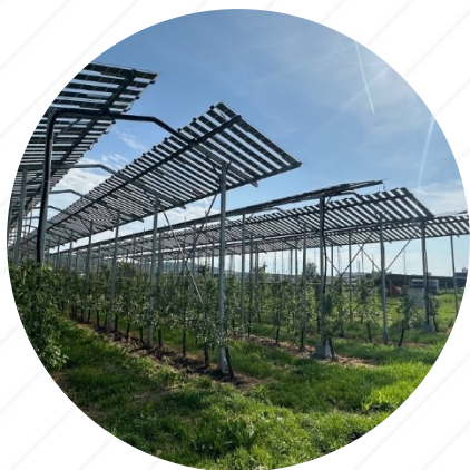
Vysoké vertikální instalace (ovoce) Orientace: východ-západ
