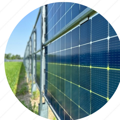
Vertikální instalace (obiliny, brambory atd.) Orientace: východ-západ
