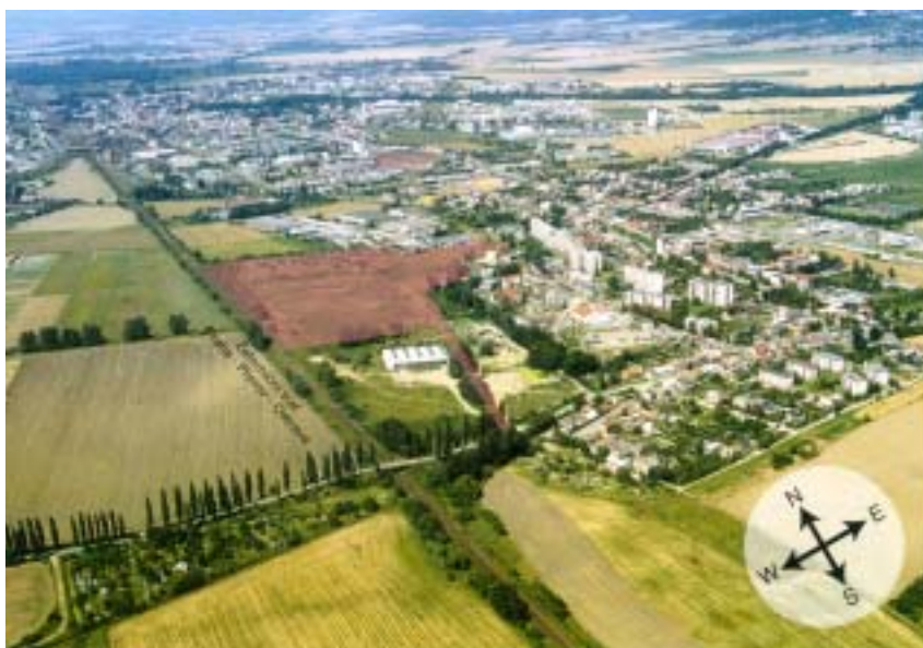
Průmyslová zóna Keplerova – původní stav
