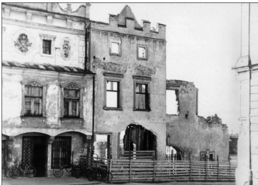
Znojmo - fotodokumentace válkou zničeného centra města
