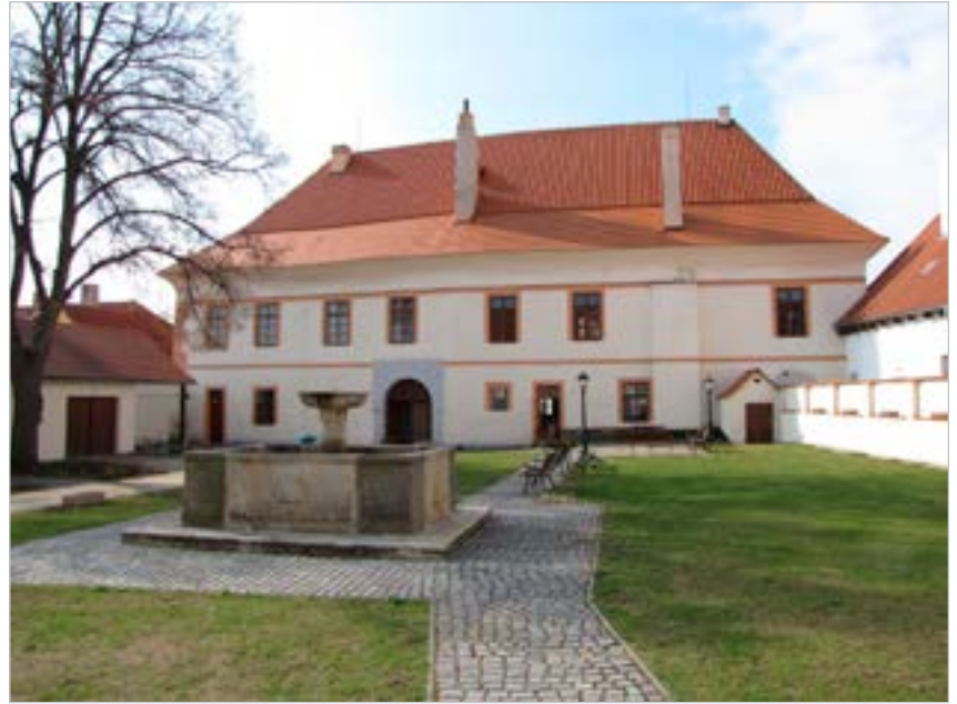
Bavorov – budova místní fary
