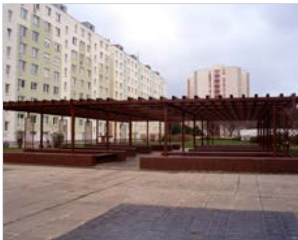
Opravená pergola vo vnútrobloku na Palkovičovej
