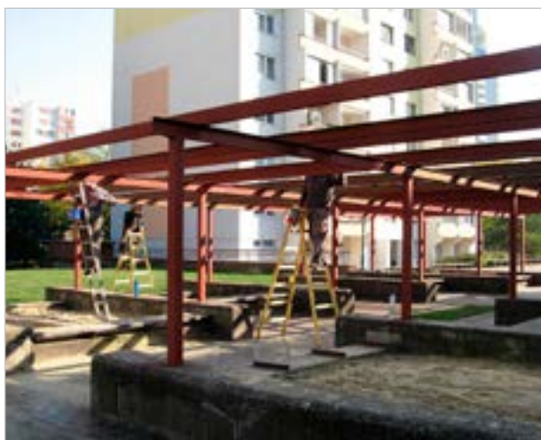
Oprava pergoly vo vnútrobloku na Palkovičovej
